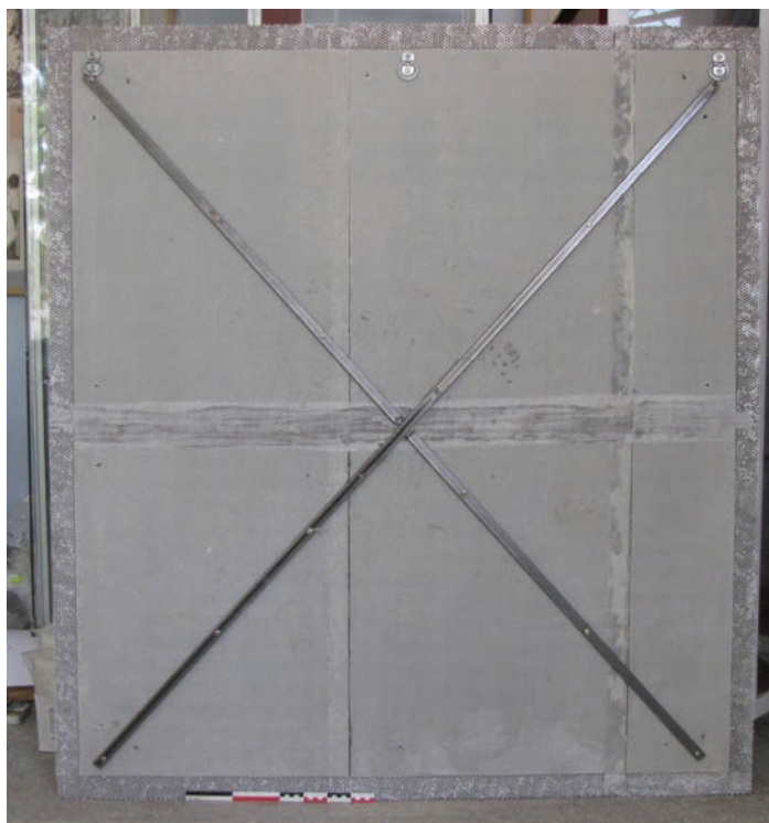
Рис. 3. Тыльная сторона монтажного щита
