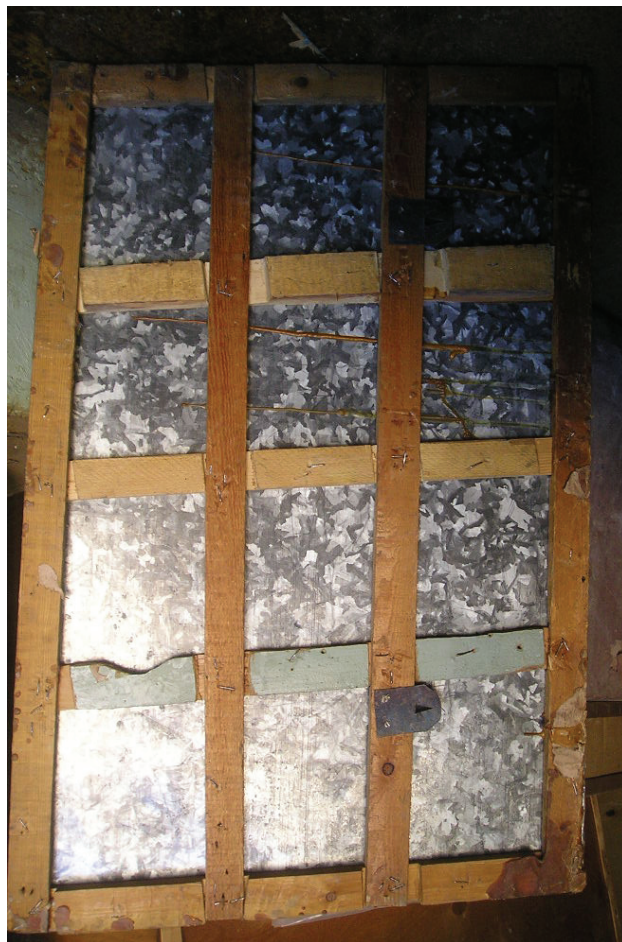
Рис. 1. Тыльная сторона старого монтажного щита из жести
