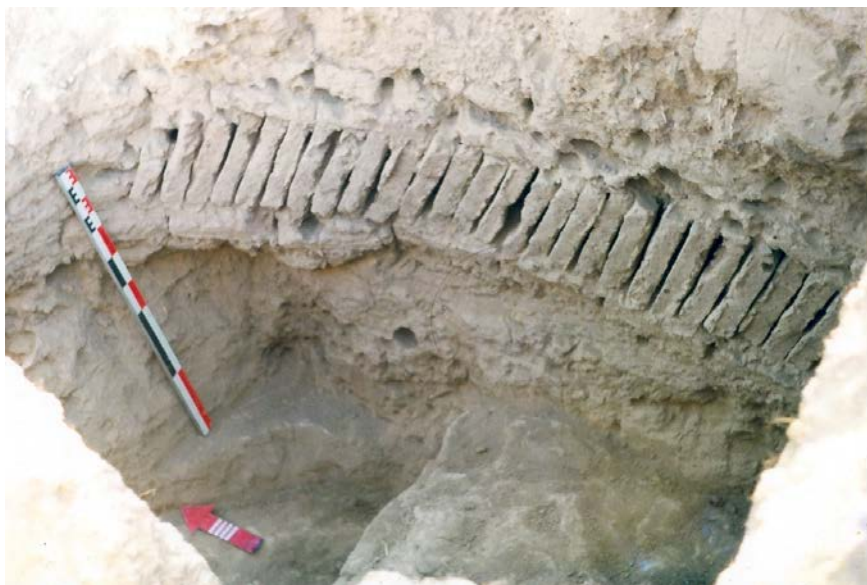
Рис. 3. Вывод из кирпичей к башне
