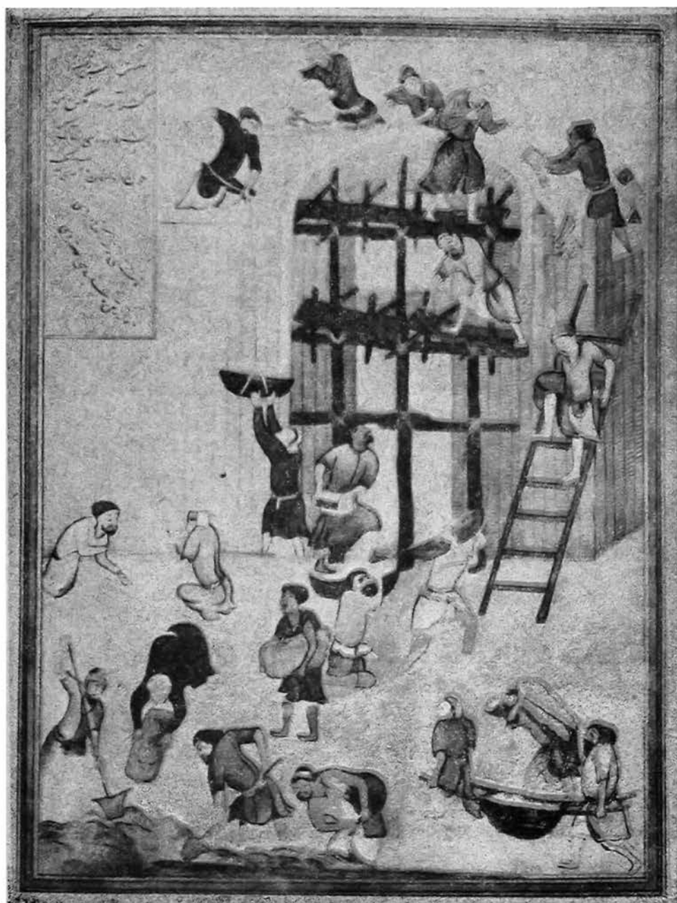
Строительные работы. Миниатюра из рукописи эпохи Навой.
