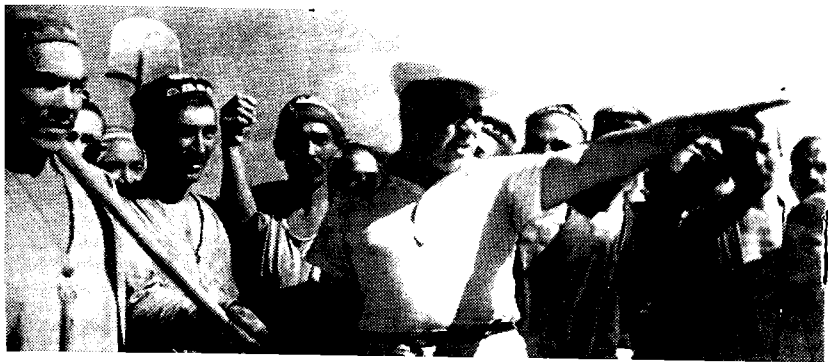
Ўзбекистон КП(б) МК секретари ўртоқ Ўсмон Юсунов Катта Фарғона канали қурилишида.
