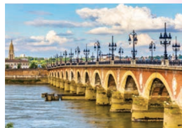
f. Bordeaux, le pont de Pierre
