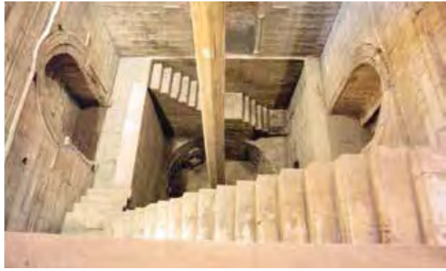
Иншооте, ки барои чен кардани сатҳи дарёи Нил аз тарафи Аҳмад Фарғонӣ сохта шудааст. Намуди берунӣ ва дохилӣ. Асри IX.
