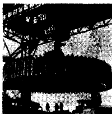
Гидрогенератор рoтoрининг мoнтaжи
