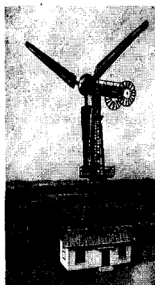
Резерв иссиқлик двигатели бўлган Д-20 маркали ярим автоматик шавоқ электр станцияси
