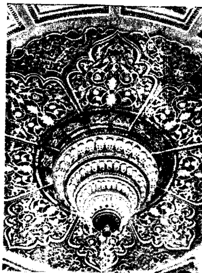
Декоративное оформление купола и люстры (отливка из алюминия, позолота, хрусталь) ГАБТ им. А. Навои. Резьба по ганчу. 1947.
