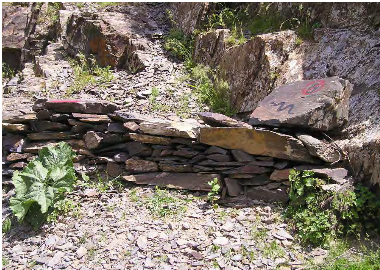
Рис. 7. Возведение стенки, ограждающей осыпь на группе IX и камень с запрещающими знаками
