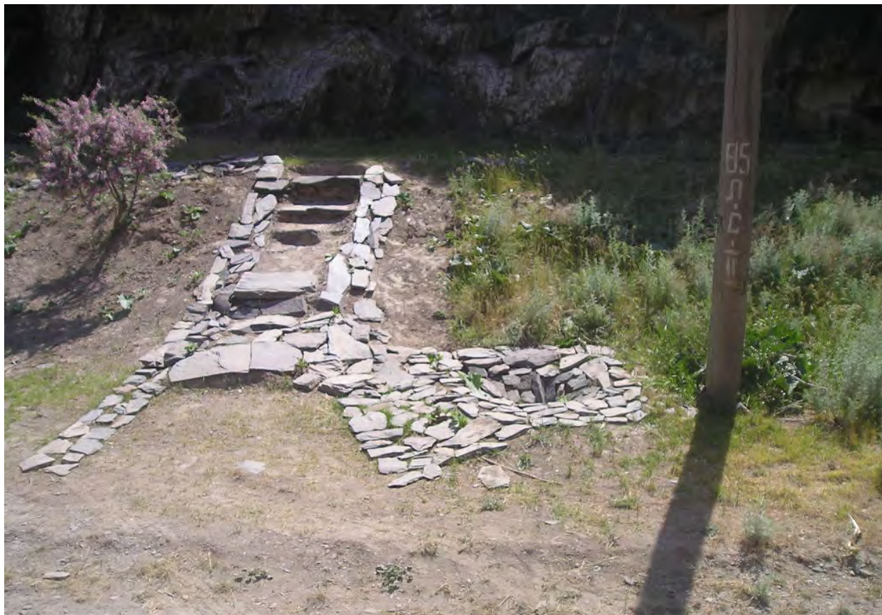
Рис. 5. Ступеньки для подъема на смотровые площадки
