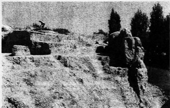
Рис. 2. Чордонатена. Северо-восточная стена, вид с юга.
