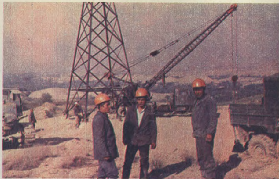
11-механизмлашган колонна электр монтажчилар бригадасида
