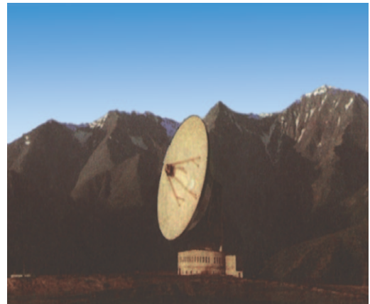
41-súwret. Jizzax wálayatı Zamin tawları eteginde qurılıp atırǵan metall aynasınıń diametri 70 metrli radioteleskop.
