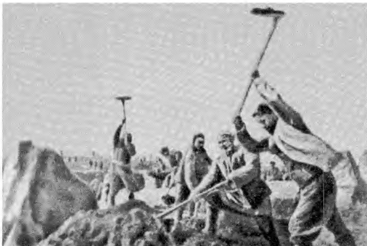
На строительстве Фархадской ГЭС
